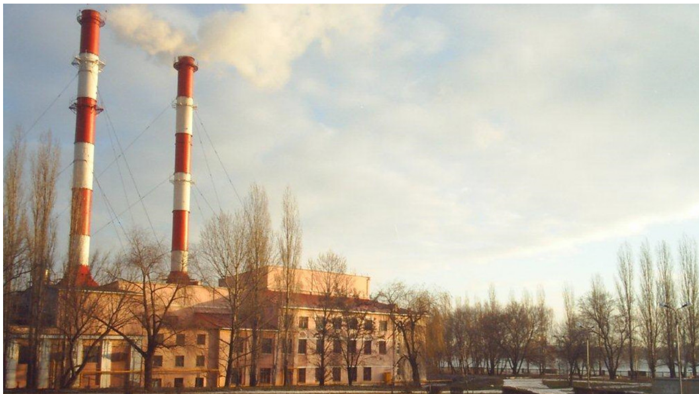
Рисунок 3 – котельная № 1 производственного подразделения Тепловые сети филиала
