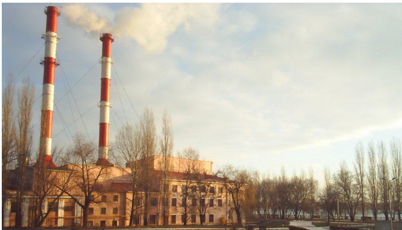
Рисунок 3 – котельная № 1 производственного подразделения Тепловые сети филиала
